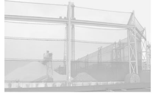
حاجز إرتفاعه 12 متر يحمي مخزون الكبريت من الرياح المحملة بغبار الفحم في جزيرة أروبا.
