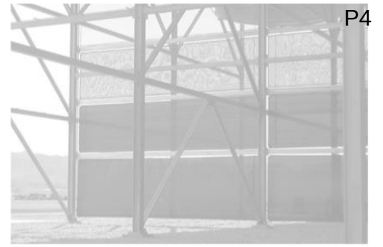
حاجز إرتفاعه 12 متر على برج تبريد في ولاية نيفادا. يصد الرياح ويحسن كفاءة المروحة في برج التبريد.
