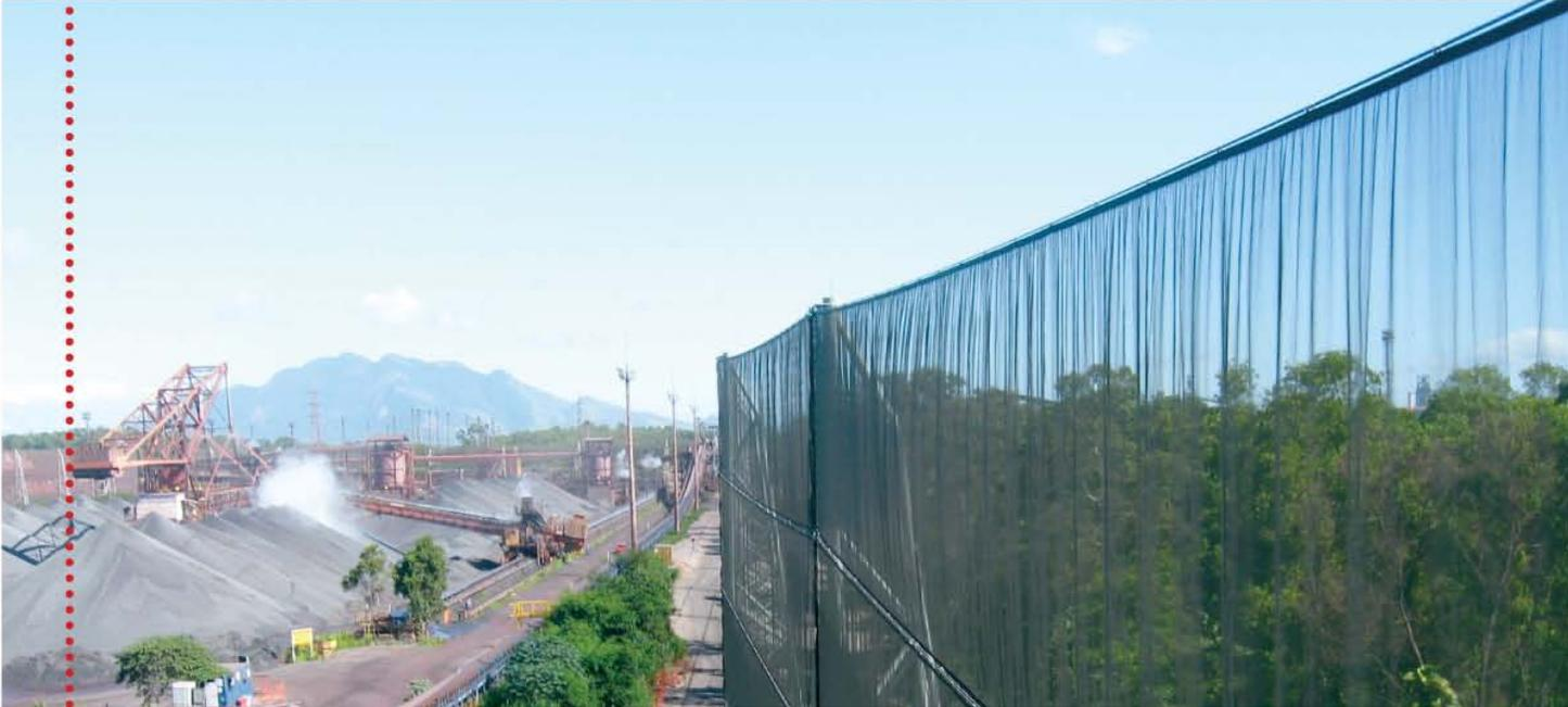
Эффективная система ветрозащиты снизит скорость ветра до уровня 40% (более чем в два раза), что уменьшит потери от пылеуноса до 16% (более чем в шесть раз)
