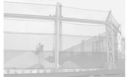
Tela de 12m (40ft) desvia o vento carregado de coque de uma pilha de armazenamento de enxofre em Aruba.
