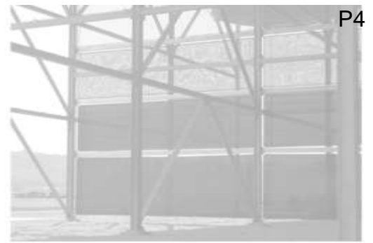
Tela de 12m (40ft) em torre de resfriamento em Nevada, desvia os ventos e melhora a eficiência do ventilador.
