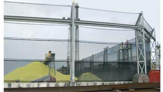
在阿鲁巴，用12米（40英尺）的筛子偏转携带焦炭的风，使硫堆免遭污染。
