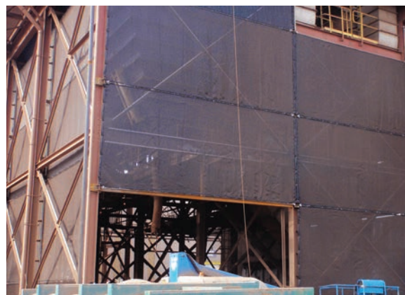
Revestimiento de torre de descarga EEUU 9m x 75m
