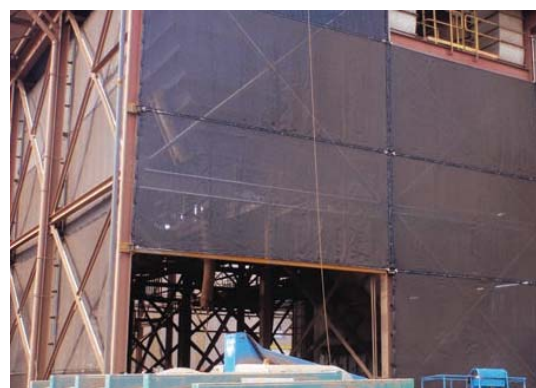
Okladzina wieży przeładunkowej 9m x 75m (USA)
