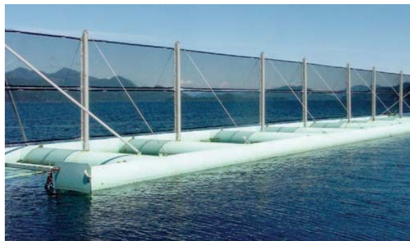
Osłona przeciwwiatrowa na falochronie pływającym .
