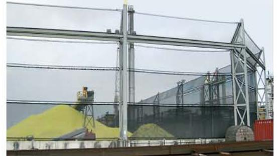
在阿鲁巴，用12米（40英尺）的筛子偏转携带焦炭的风，使硫堆免遭污染。
