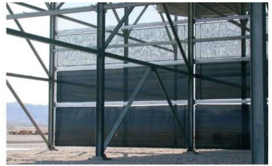
在内华达州的冷却塔12米（40英尺）筛子，用于偏转风的方向和提高风扇的效率。
